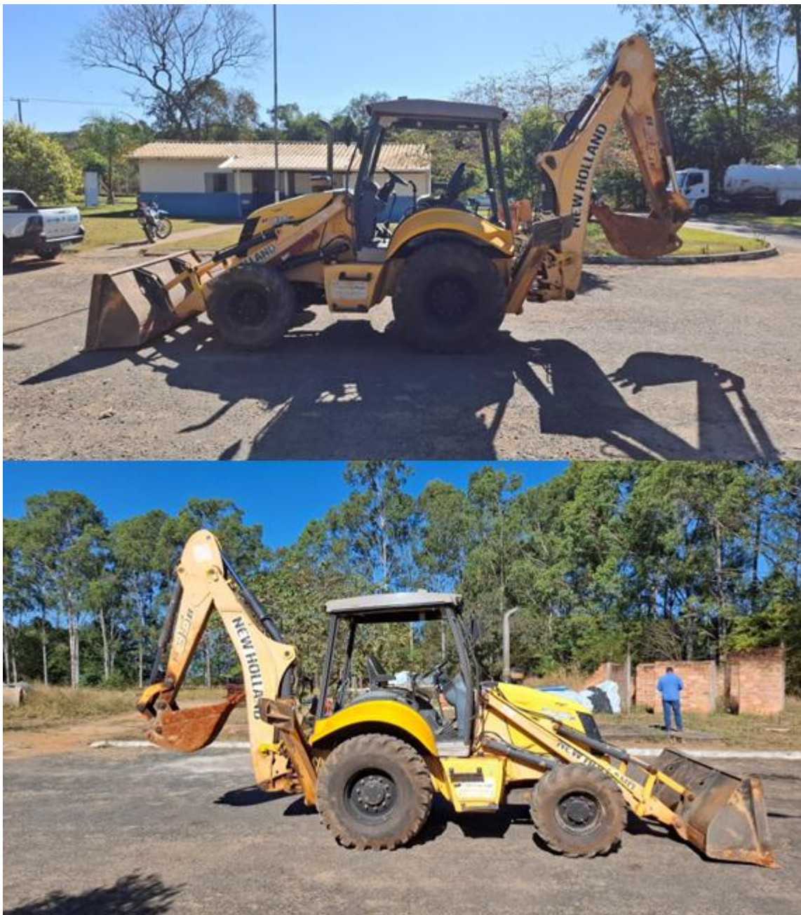
(Estação de Tratamento de Esgoto- Parque Real)
